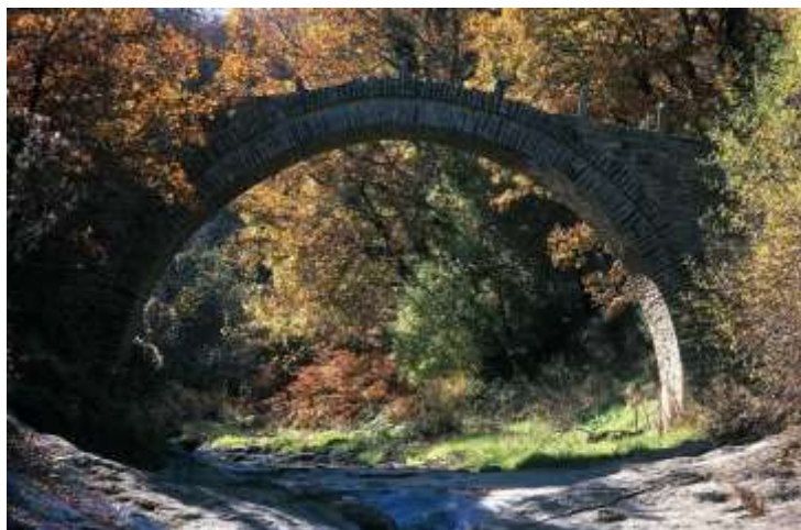
Εικόνα 6. Το γεφύρι του Κάστρου στον ποταμό Γρεβενίτη
